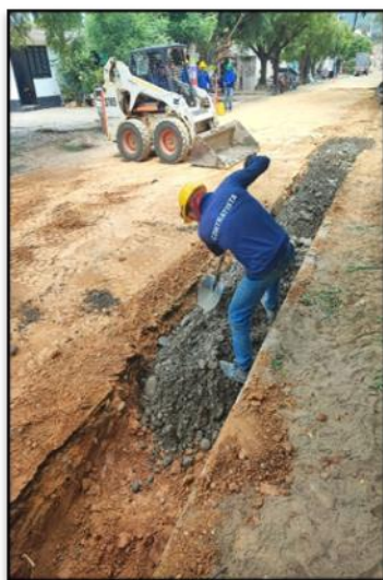
Registro fotográfico rellenos con material sub-base granular
