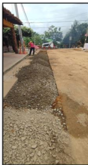
Registro fotográfico rellenos con material sub-base granular
