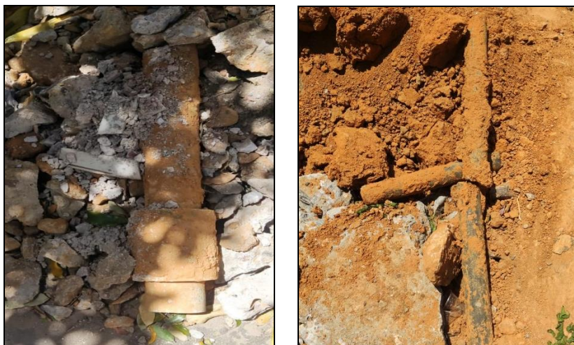
Registro fotográfico N.2- tubería extraídas en los sectores intervenidos en asbesto cemento
