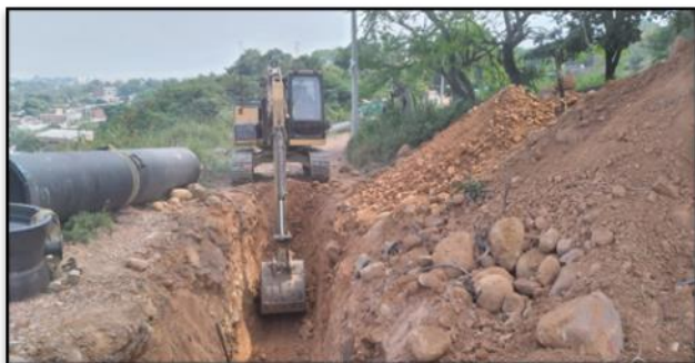
Registro fotografico. Excavación mecánica
