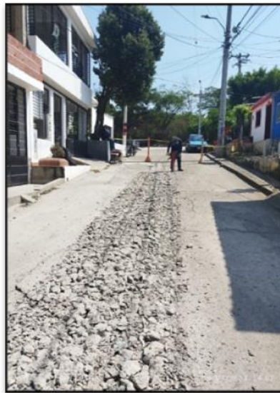
Demolición de pavimento
