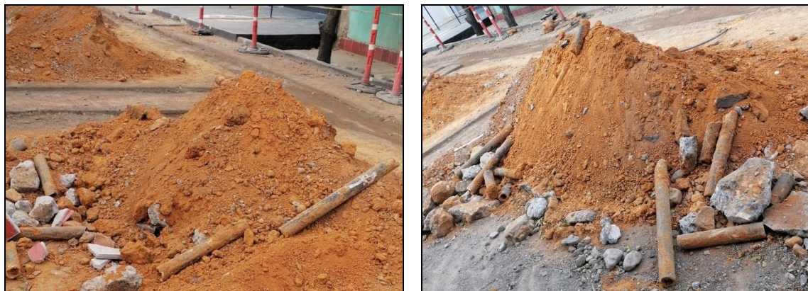
Registro fotográfico N.1- tubería extraídas en los sectores intervenidos en asbesto cemento
